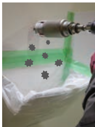
壁面穴あけ作業時の粉塵受け
