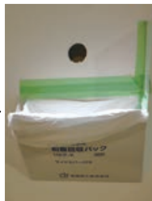
壁面穴あけ作業後
